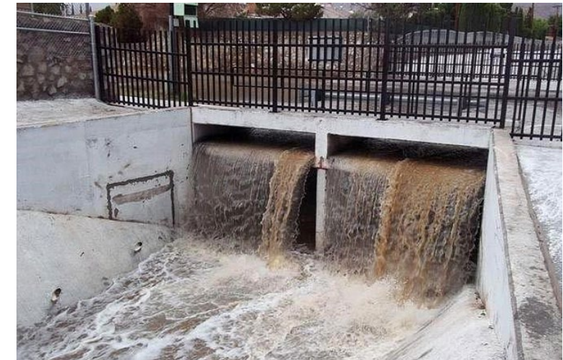
El Paso storm water project, El Paso, TX
